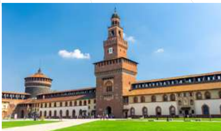
03. Castello Sforzesco, Milano Rivellino di Santo Spirito
